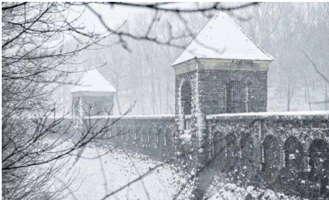
Die Talsperre Euba wurde von 1911 bis 1914 zur Wasserversorgung der Dampflokomotiven im Rangierbahnhof Chemnitz-Hilbersdorf gebaut. Die Mauer besteht aus den Gesteinen, die aus dem benachbarten Steinbruch, dem späteren Eibsee, gewonnen und mit einer Feldeisenbahn zum Stausee befördert wurden. Die Staumauer hat eine Länge von 184 Meter, die Höhe beträgt 14,5 Meter. Sie hat ein Fassungsvermögen von etwa 160.000 Kubikmetern. Foto: Andreas Seidel
